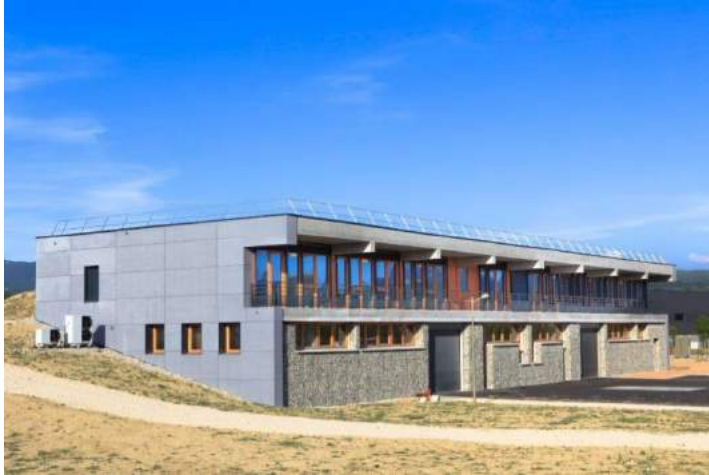
Bâtiment du pôle bio à l'Ecosite d'Eurre
