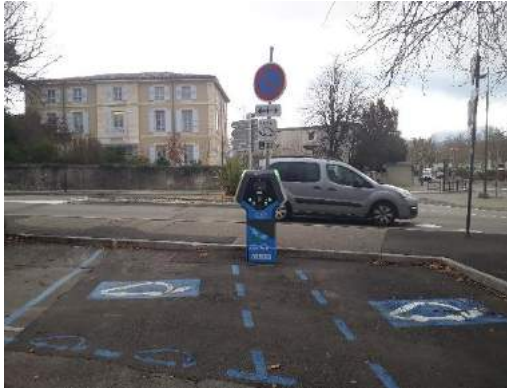
Bornes de recharge à Crest
